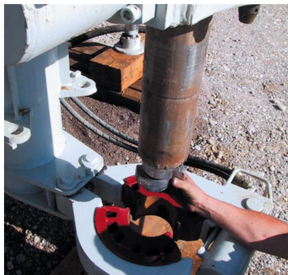
Bohrkopf der Bohranlage mit einem Durchmesser von ca. 20 cm
