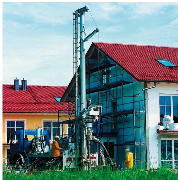
Bohrung für die Erdsonde
