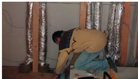
Installation der Luftleitungen
