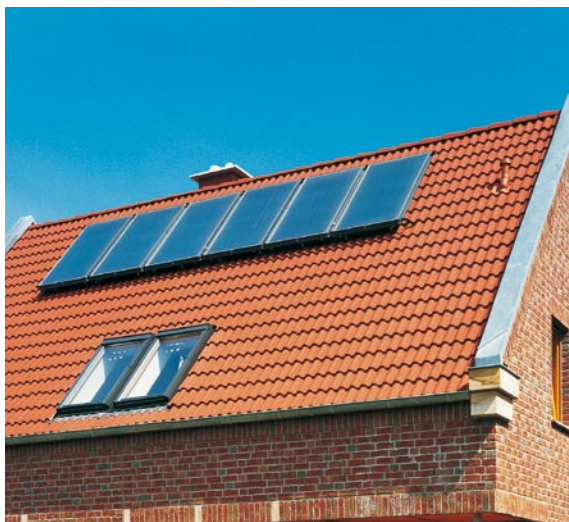
Solaranlage mit Flachkollektoren Bild unten: Schematischer Aufbau eines Flachkollektors
